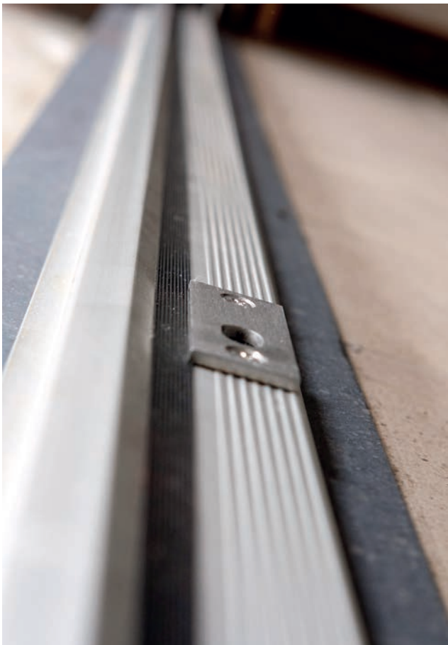
Detail thermisch onderbroken onderprofiel
