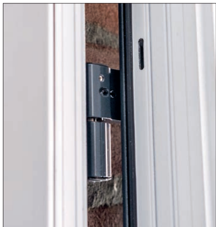
Detail scharnier binnenzijde
